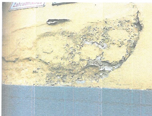
Solí krystalizují na povrchu až nad teracovým obkladem
