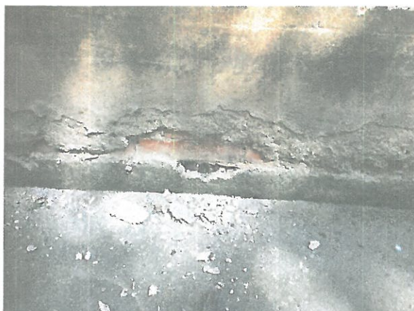
Téměř žádné ošetření proti odstříku – vápenné omítky silně zdegradované
