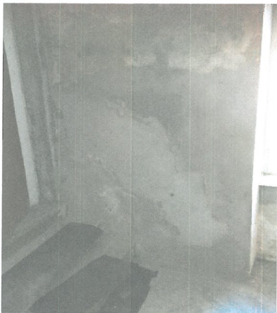
Konstrukce zvlhává vlivem zvýšeného terénu a podlahy vstupu
