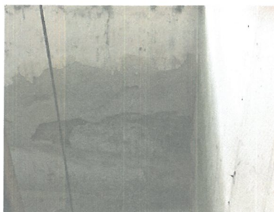
Výtahová šachta je zasažená vlhkostí, která působí zrubu konstrukce vlivem sníženého dna šachty vůči podlaze 1.PP a vůči terénu .
