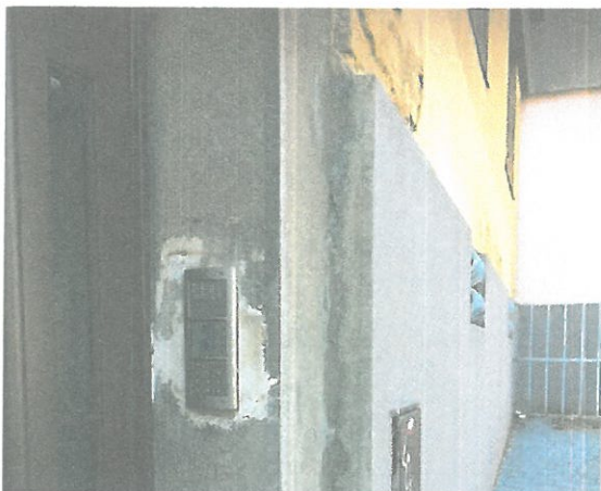
Tlak vlhkosti a solí na rub teraca je zcela zřejmý
