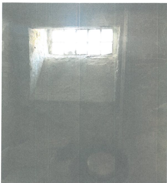
Obvodová konstrukce ze strany 1.PP je viditelně zavlhlá až na stropní klenbu. Z vnitřní strany jsou aplikovány cementové neprodyšné omítky, které vlhkost vytlačily společně s vnějším teracem až do stropu .
