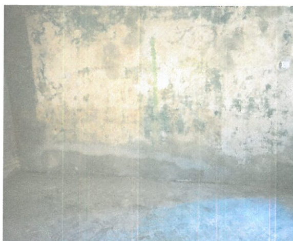
Konstrukce zvlhává vlivem zvýšeného terénu a podlahy vstupu
