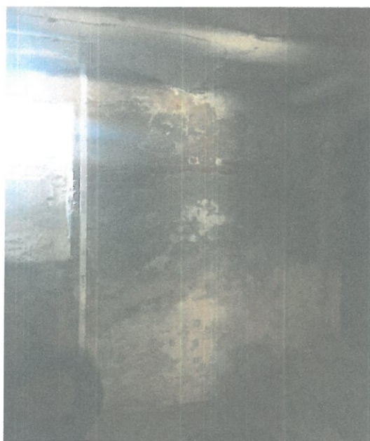
Obvodová konstrukce ze strany 1.PP je viditelně zavlhlá až na stropní klenbu. Z vnitřní strany jsou aplikovány cementové neprodyšné omítky, které vlhkost vytlačily společně s vnějším teracem až do stropu .
