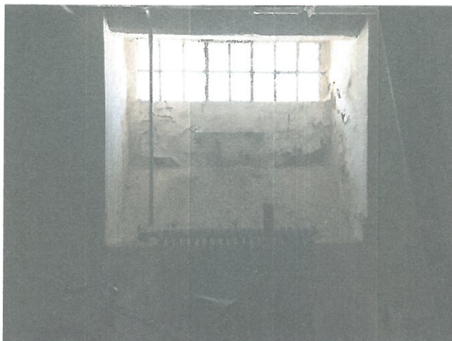
Je možné, že otvor byl zmenšen a zazděn bez provedení svislé izolace
