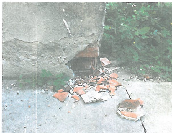
Vlivem špatného napojení svislé a vodorovné izolace zdivo nad izolací degraduje
