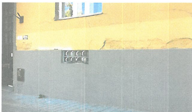
Vlhkostní projevy jsou na pravé straně až v úrovni 1.NP
